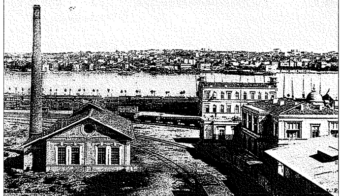
Haydarpaşa Limanı tesislerinin planı (Wolfgang Müller-Wiener, Die Häfen von Byzantion, Konstantinopolis Istanbul , Tübingen 1994, lv. 53/2) ve Haydarpaşa Limanı'nı gösteren eski bir kartpostal (İstanbul Belediyesi Atatürk Kitaplığı kartpostal koleksiyonu)
